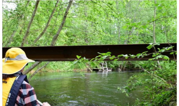
Korkean veden aikana alkukesällä tässä sillassa on kumarruttava ja varottava päätä
